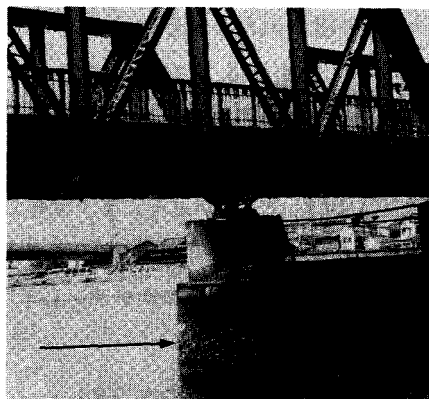
図7 長浜大橋の橋脚に付着するマガキ
